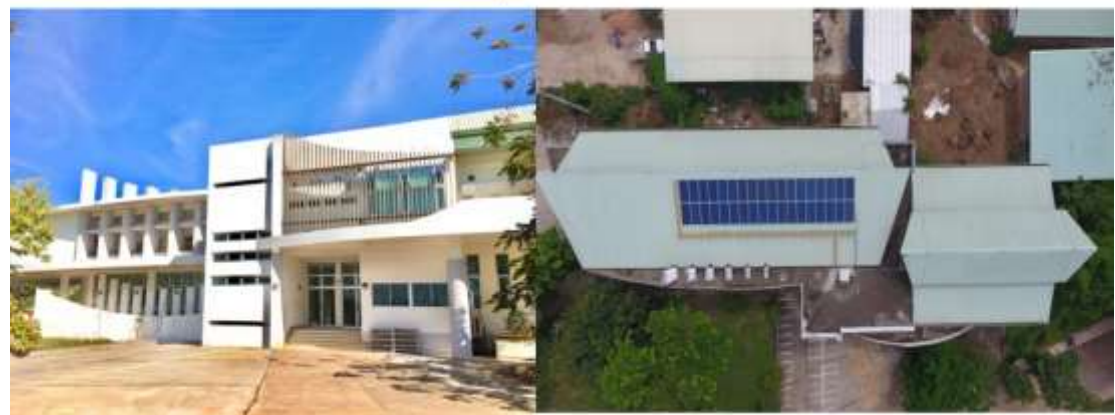
รูปที่ 2 ภาพรูปการณ์ติดตั้งระบบผลิตไฟฟ้าด้วยเซลล์แสงอาทิตย์บนหลังคา (ต่อ)
