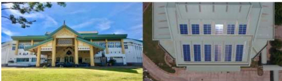
อาคารสำนักงานอาคารสถานที่และยานพาหนะ
