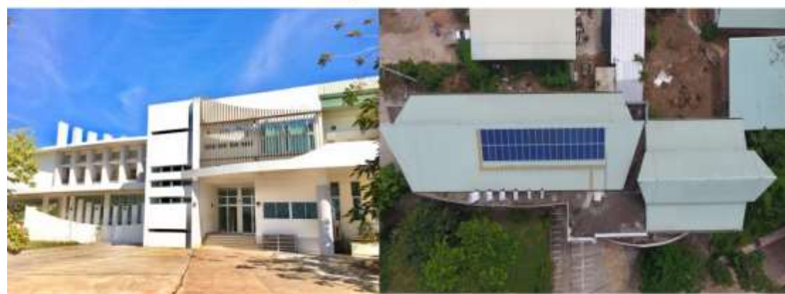
รูปที่ 2 ภาพรูปการณ์ติดตั้งระบบผลิตไฟฟ้าด้วยเซลล์แสงอาทิตย์บนหลังคา (ต่อ)
