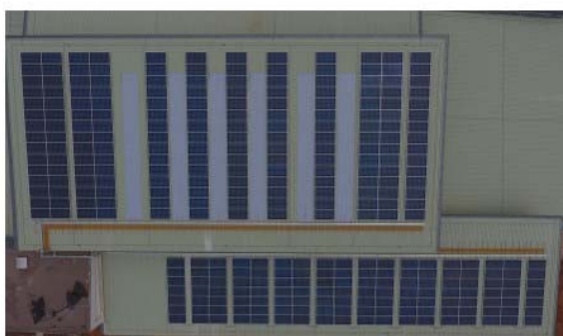
รูปที่ 1 ภาพรูปการณ์ติดตั้งระบบผลิตไฟฟ้าด้วยเซลล์แสงอาทิตย์บนหลังคา
